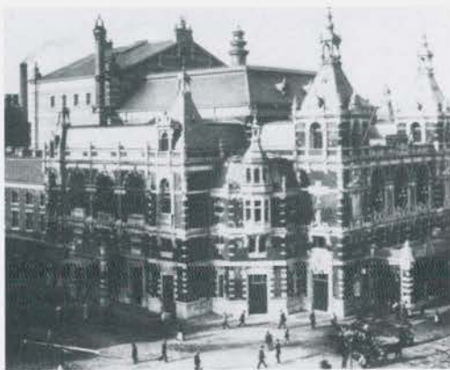
De nieuwe Stadsschouwburg aan het Leidse Plein, 1894.
