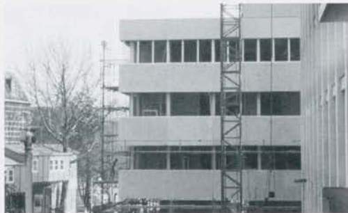
De polikliniek in aanbouw 1966.
