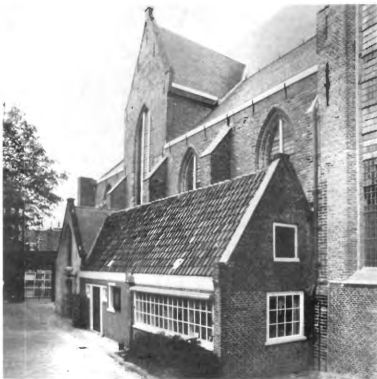
Voormalige St. Janskerk, zuid-westgevel. Sinds 1936 als Gemeente-archief in gebruik. (foto: Gem. bureau Monumentenzorg, Bedrijf Openbare Werken)
